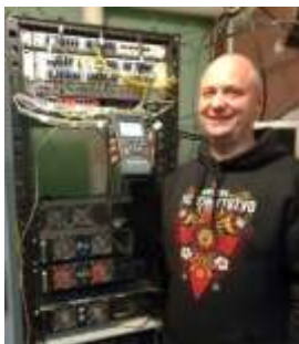
Рисунок 1 – Вимірювання параметрів оптичного волокна на вузлі агрегації телекомунікаційної компанії ТОВ «ТВОЙ НЕТ» рефлектометром EXFO AXS-100.
