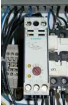
Рисунок 1 -Електромагнітне реле часу
