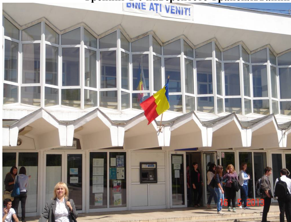
Рисунок Д. 1 – Учебный корпус Университета Трансильвании
