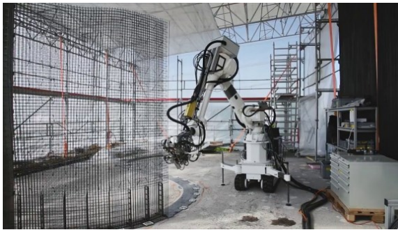
Рисунок 1 – Використання будівельної робототехніки на майданчику
