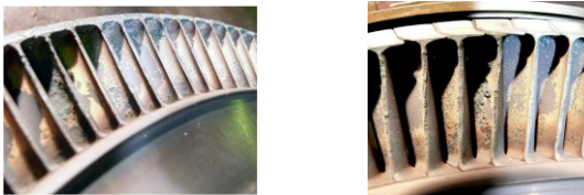
Рисунок 3 – Корозійне пошкодження робочих лопаток турбіни внаслідок дії на лопатки сірчистих з'єднань у зонах дії найбільших температур.
