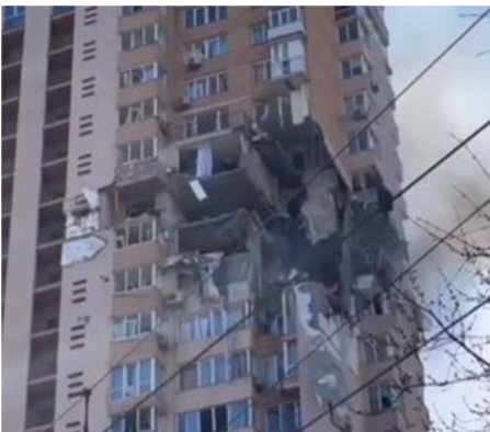
Рисунок 1 – Пошкодження будівельних конструкцій після влучання снаряду
