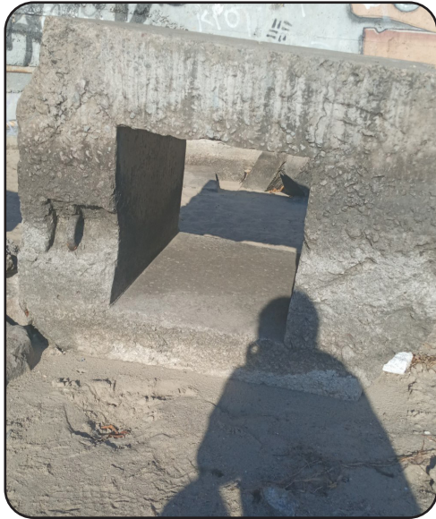
■ Фундамент будинку. Фото авторки
